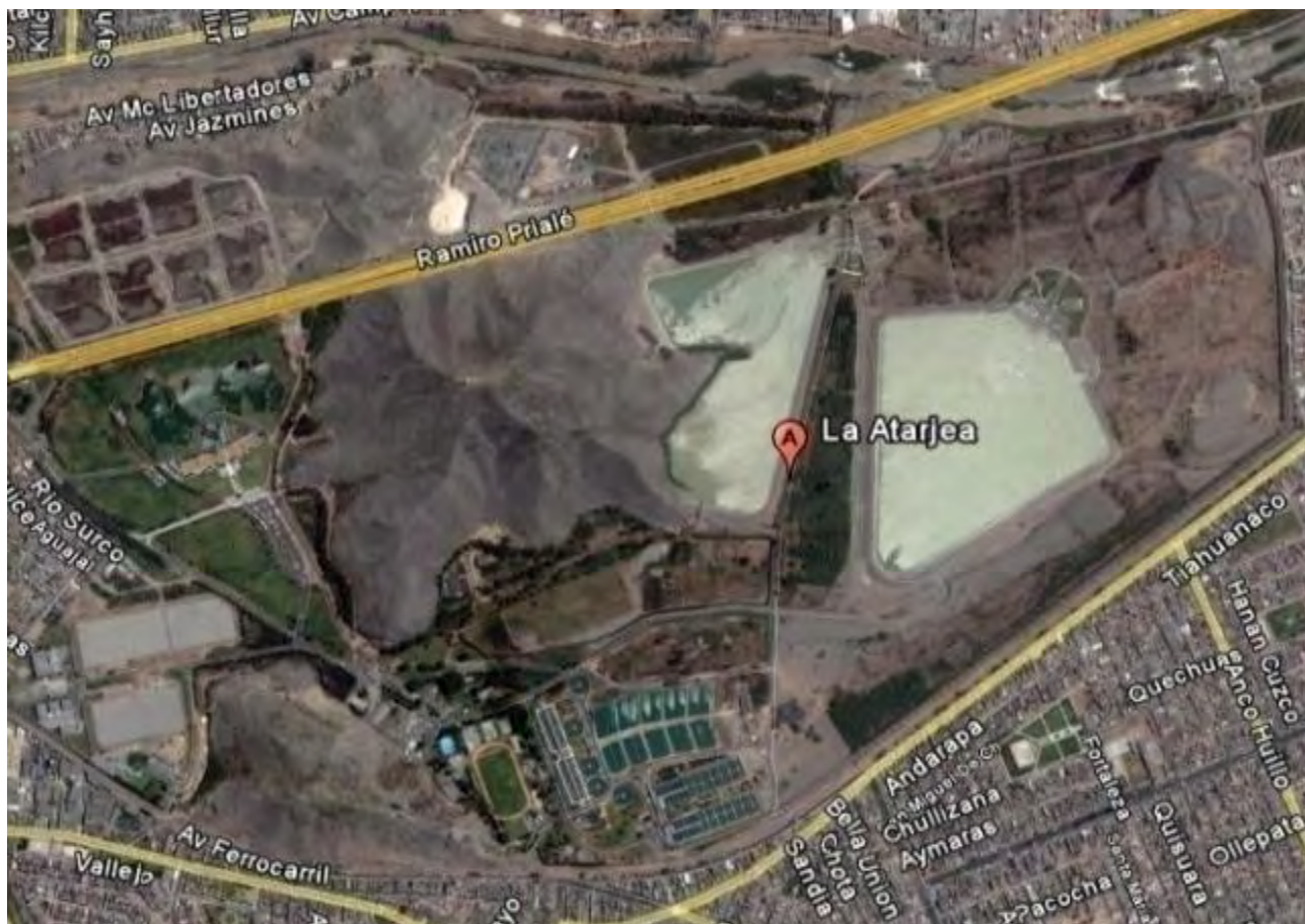
RIO RIMAC: Vista panorámica de la planta de tratamiento La Atarjea. 2011
